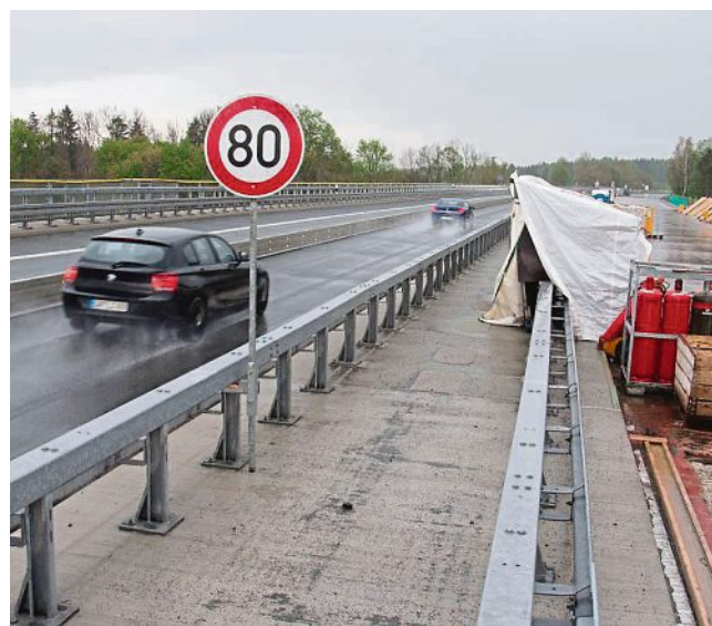
Langzeit-Baustelle: Auf der Mühlbachtalbrücke wird seit gut einem Jahr gewerkelt.
